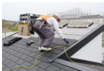
屋根の断熱化工事
