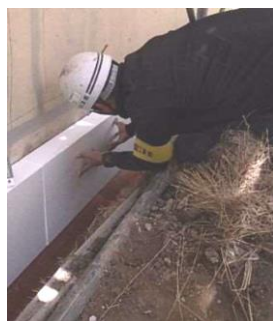
外壁の断熱化工事
